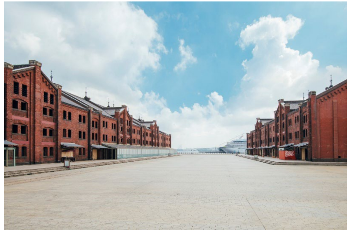
横浜赤レンガ倉庫 外観
