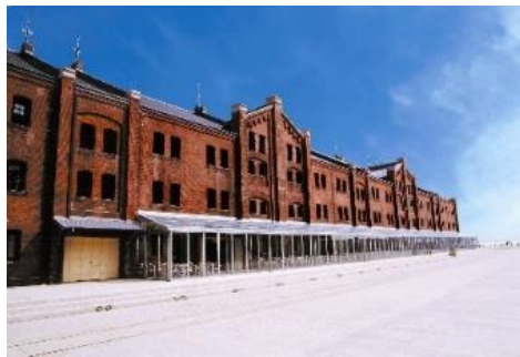
< 横浜赤レンガ倉庫 外観 >
